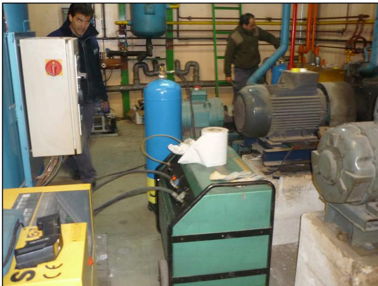
**12/01/2010.** Se procede a la carga de la instalación con el HFC R-434A (RS-45), en total 550 kg. Ya que con R-22 la instalación había perdido parte de la carga. Se ajusta la instalación y se comprueba el nivel de aceite.
