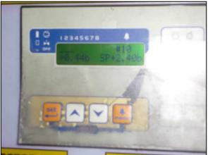
10.12 h. Se inicia la carga del R-434A (RS-45) HFC. En total 50 kg. (Carga incompleta).
